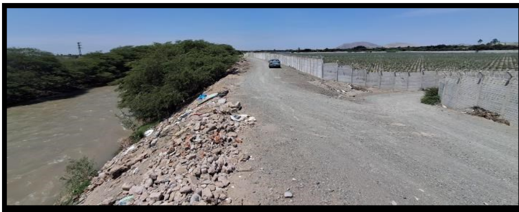
FIGURA N°3: EN ESTE PUNTO EL AGUA SE DESBORDA POR LA CRECIDA DEL RIO, HACIENDO DAÑO A LA VIA, CULTIVOS, CERCO PERIMETRICOS, ETC
